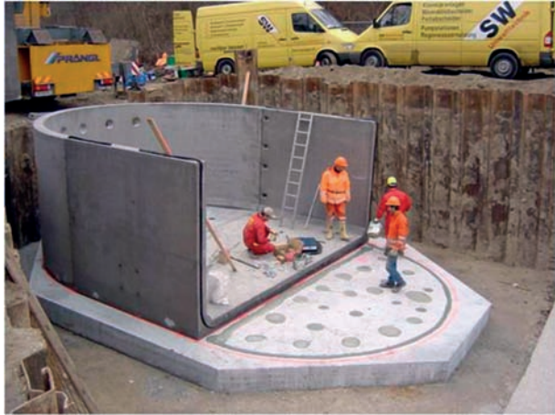
Figura 5.5 Esempio di vasca di sedimentazione prefabbricata in costruzione (fonte: KMC S.r.l.)
