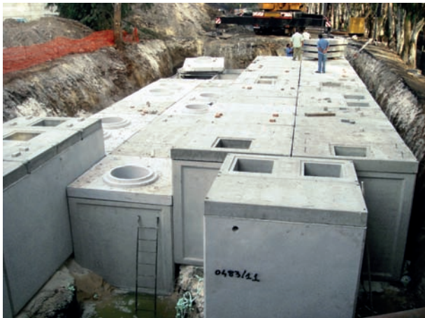
Figura 5.6 Esempio di vasche di sedimentazione prefabbricate dotate di passo d'uomo e posizionate in parallelo dopo uno scolmatore (in primo piano) (fonte: Musilli S.p.A.)
